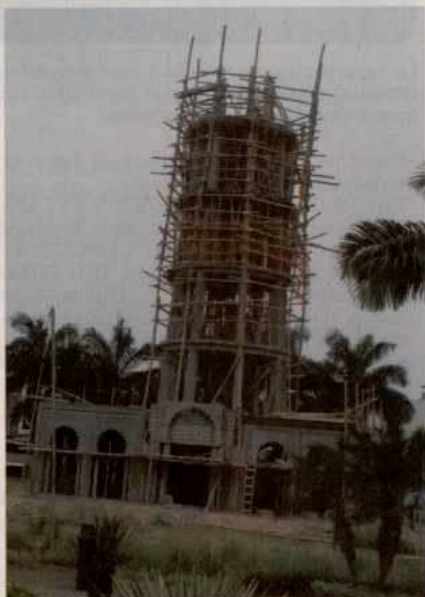
Torre reloj mirador, que se construye en Ciudad Universitaria Milagro
